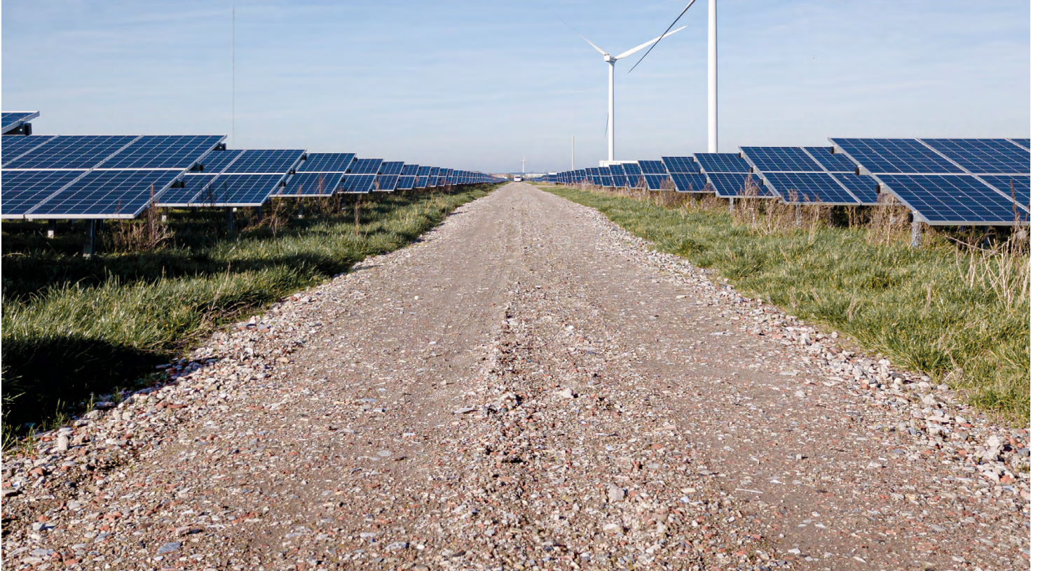
Energiepark Haringvliet Zuid, Middelharnis
